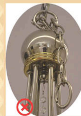
把多余的吊链拆下来给业主保管，以作为后期调整灯具高低时使用。
