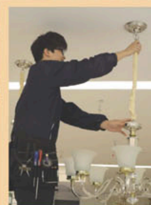
安装工程师在安装灯具时，属于天花作业，于安装时应带齐所需工具及零配件以避免安装过程中缺少工具及配件而造成浪费时间及增加安装难度。
