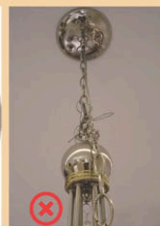
应该把保险钢丝绳锁定，吸顶盘的壁板内。
